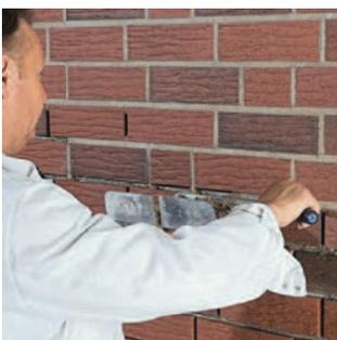
Швы открытопористых плиток заделывают Раствором для заполнения швов RFS с помощью расшивки и
