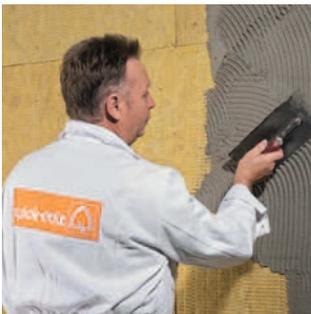
На теплоизоляционные плиты, в данном случае минераловатные, приклеивают Клеящим раствором для керамической плитки RKS, наносят первый слой армирующего раствора RAS толщиной ~ 5 мм. В него с помощью гладилки вдавливают утолщенную Армирующую сетку PUG.
