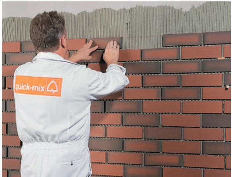
После полного затвердевания армирующего слоя приклеивают плитки методом «Buttering-Floating»: зубчатым шпателем (10x10 мм) наносят слой RKS на поверхность основания, в который вдавливают плитки, покрытые миллиметровым слоем RKS с изнаночной стороны.
