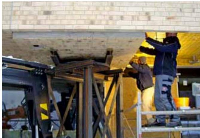
Montage der vorgefertigten Deckenplatten. Deutlich zu sehen: Die Trägerschicht aus Beton und die Sichtseite mit Klinker-Riemchen.
