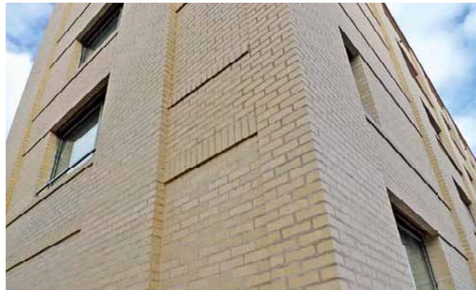
Eckbereich mit Stürzen und Rollschichten aus Ziegel-Fertigteilen.
