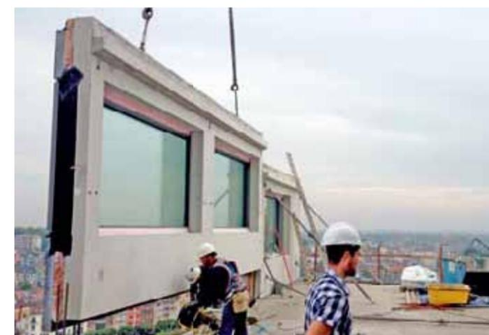
Die Sandwich-Elemente wurden im Werk vorgefertigt und vor Ort in der Stahlbetonkonstruktion verankert.
