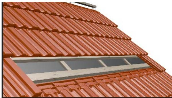
Прикрепить дополнительный монтажный брус к конструкции кровли. Высота установки бруса зависит от модели черепицы.
