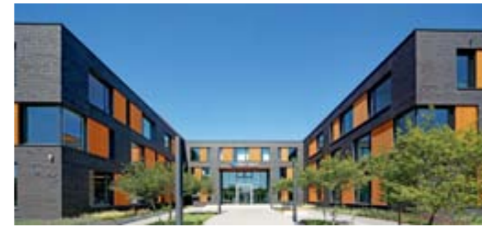
Gelungene Materialkontraste - Verwaltungsgebäude, Löhne, Seite 74
