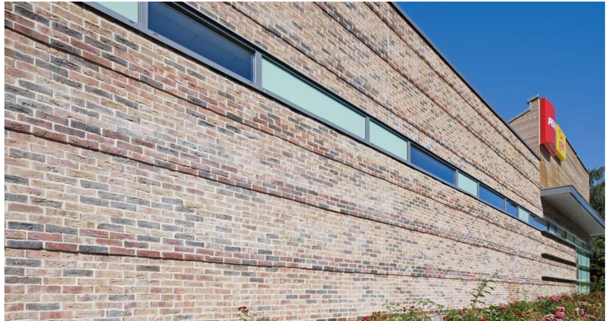
Die horizontalen Fassadenbänder entstanden durch zwei unterschiedliche Rößen Handform-Riemchen: MOORBRAND torf-bunt und DYKBRAND flämisch-bunt, jeweils in zwei verschiedenen Stärken, 14 mm und 35 mm als Sonderanfertigung.
