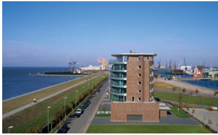
Objekt Wohnanlage „Weser Loft“ in Bremerhaven Architekten JPS Joost, Philipps, Schulz, Bremerhaven Fassade Röben Architektur-Klinker WESTMINSTER
