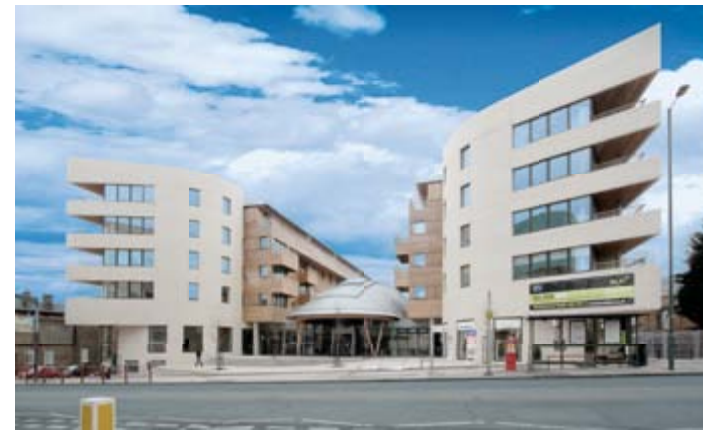
Objekt Multifunktionskomplex in London (GB) Architekten Edward Cullinan Architects, London (GB) Fassade Röben Keramik-Klinker VERSAILLES, eine Sortierung des OSLO perlweiß
