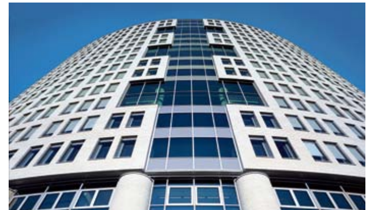
Objekt ABC-Tower, Köln, Bürogebäude mit 17 Etagen Architekt Engelbert Zepp, Erftstadt Fassade Röben Keramik-Klinker OSLO, carrara-weiß, Architekten-Sortierung
