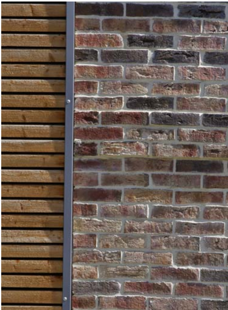
Die horizontalen Fassadenbänder entstanden durch zwei unterschiedliche Rößen Handform-Riemchen: MOORBRAND torf-bunt und DYKBRAND flämisch-bunt, jeweils in zwei verschiedenen Stärken, 14 mm und 35 mm als Sonderanfertigung.
