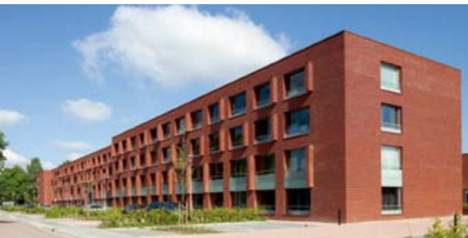
Tiefe Einschnitte – Wohnsiedlung in Tilburg (NL) Seite 24
