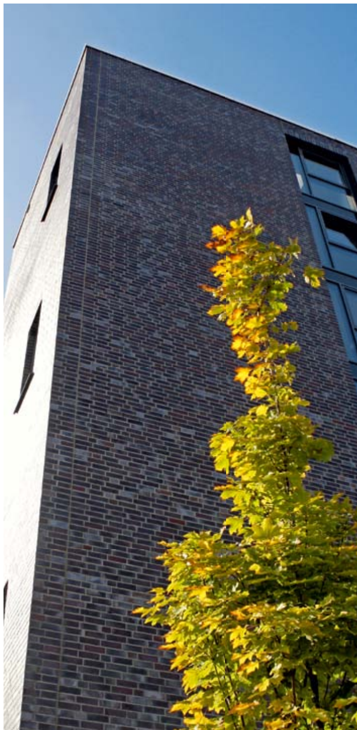
Die Klinkerfassade wurde „frisch in frisch“ - Mauern und Verfugen in einem Arbeitsgang - verarbeitet, um etwaige Schwachpunkte in den Fugen zu vermeiden. Der Röben Klinker OXFORD in alt-englischem Dunkelrot mit silbernen Anflammlungen belebt die großen Fassadenflächen
