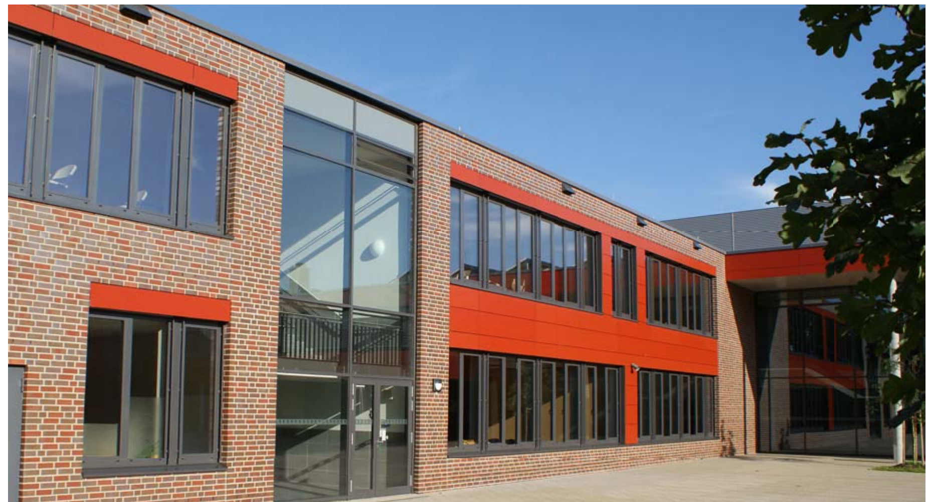
Entlang der Dachkanten wurden insgesamt zwanzig Fledermausquartiere an der Fassade angebracht.
