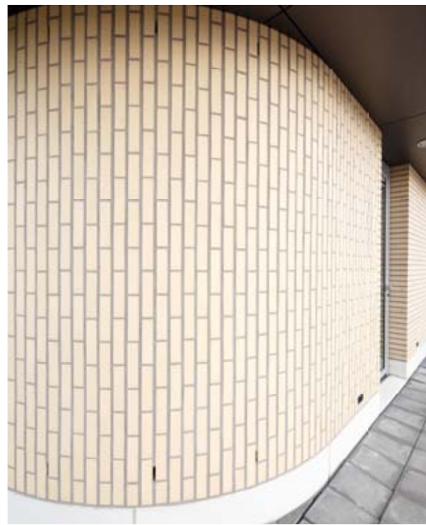
Mauerwerk in verschiedenen Ausführungen: Mal als Stapelverband, mal als vertikal gesetzte Klinker für gerundete Fassadenabschnitte.
